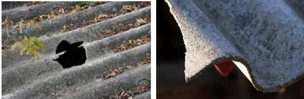
Zdjęcie 3 Płyty faliste azbestowo- cementowe
